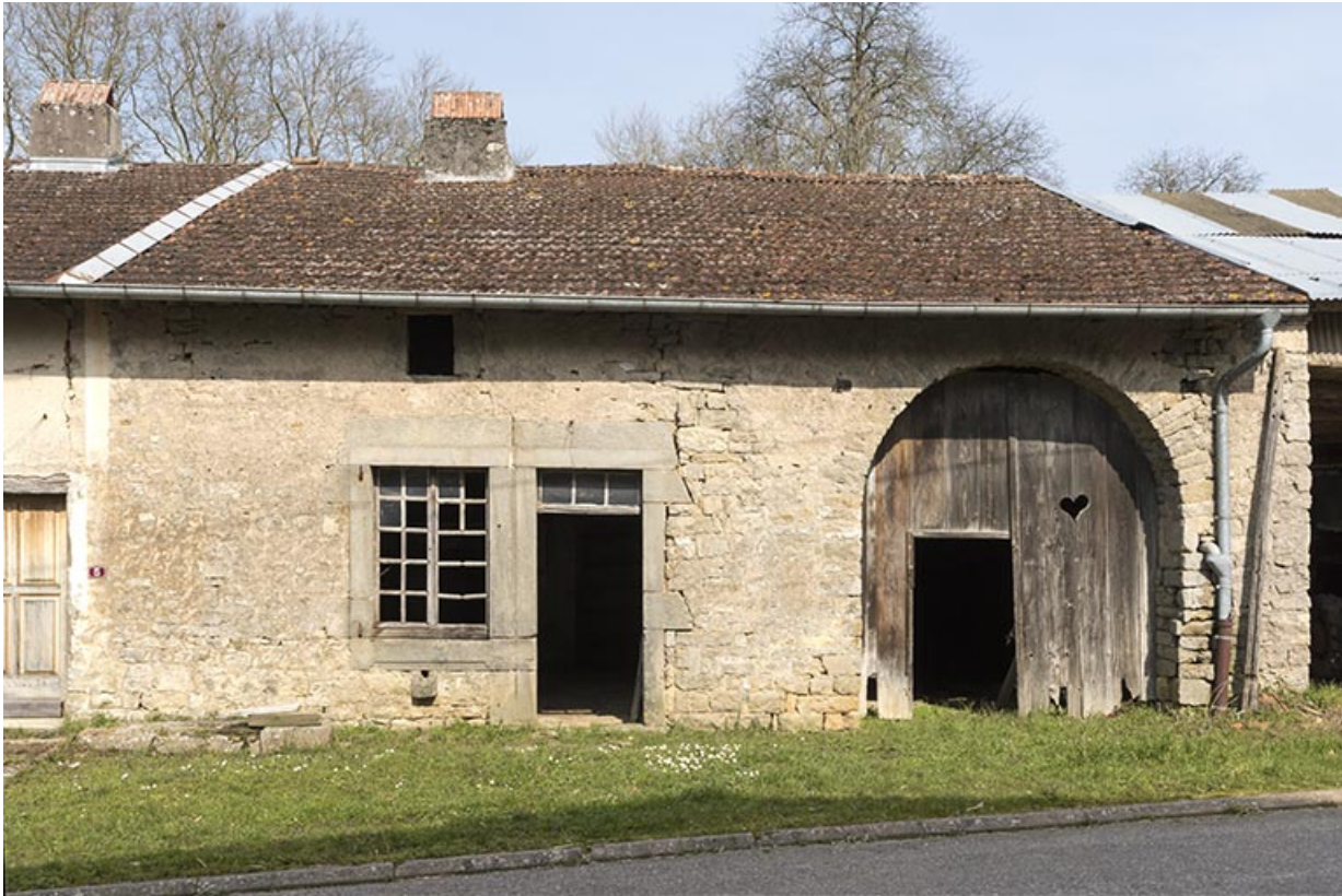
ferme à deux travées. 70, Aisey-et-Richecourt
