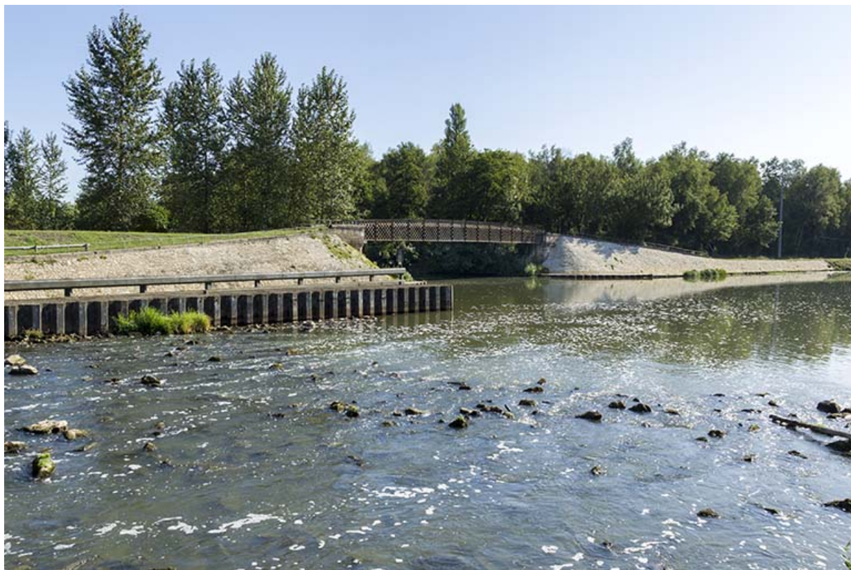
Passerelle sur la Lanterne, au confluent avec la Saône, vue de la rive droite en amont. 70, Conflandey
