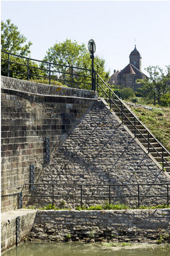
Détail de l'accès au pont par un escalier indépendant.
