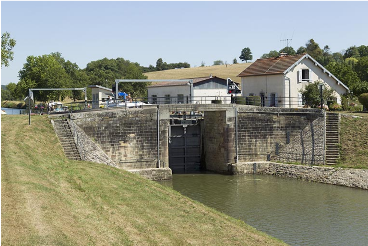
Depuis la rive droite en aval, vue sur l'écluse et le site.
