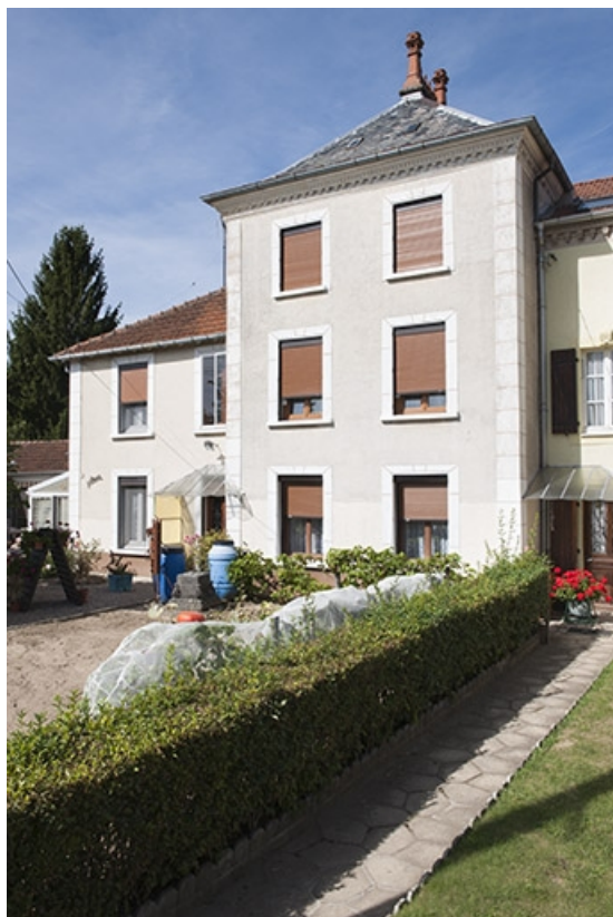
Façade antérieure, partie ouest.
