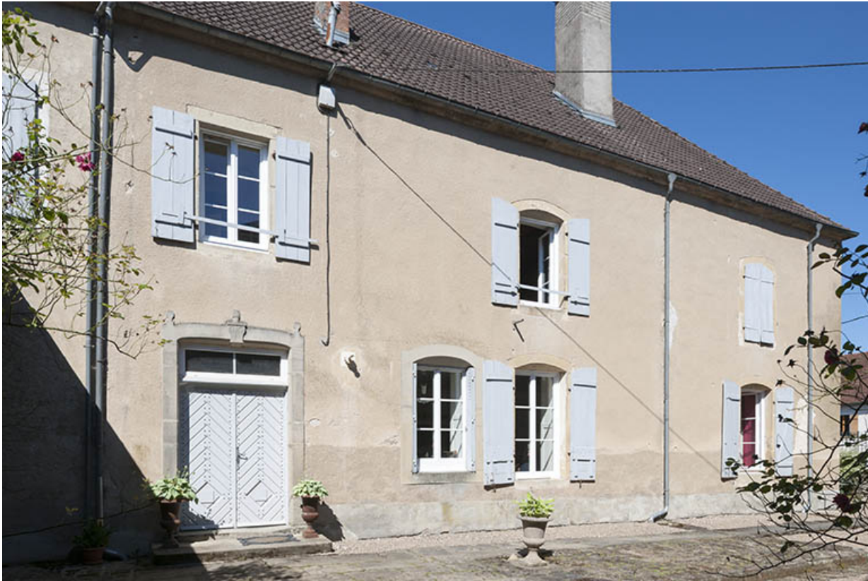
Vue générale, façade est.
