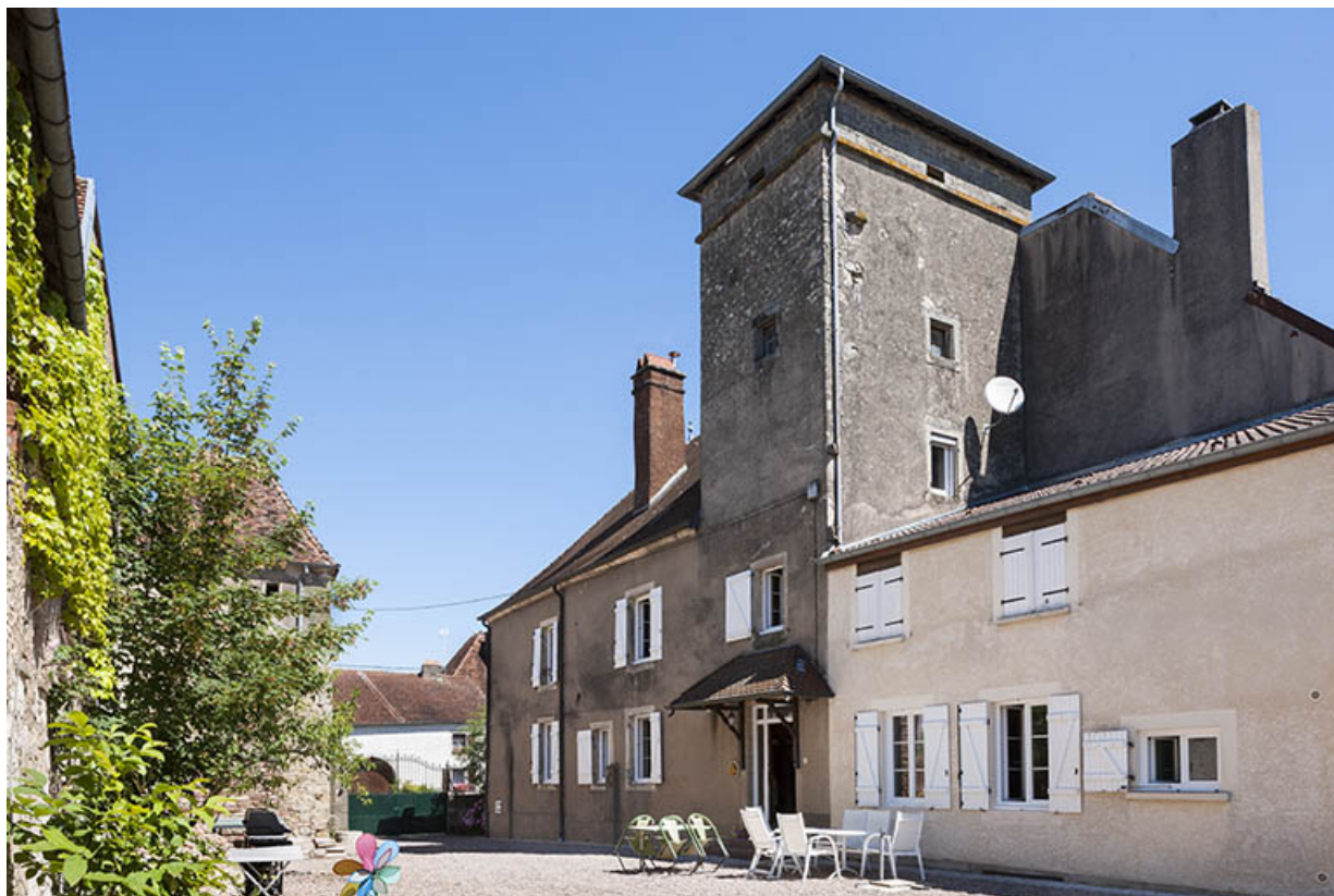
Vue générale, façade ouest.
