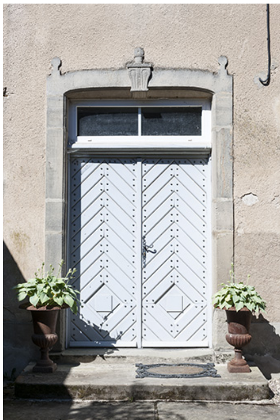
La porte d'entrée, façade est.
