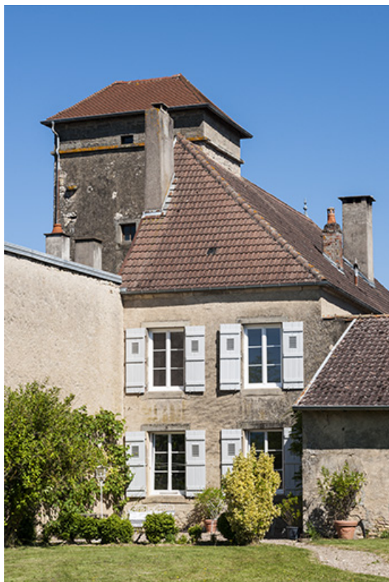
Façade postérieure de la partie est avec la tour en arrière plan.
