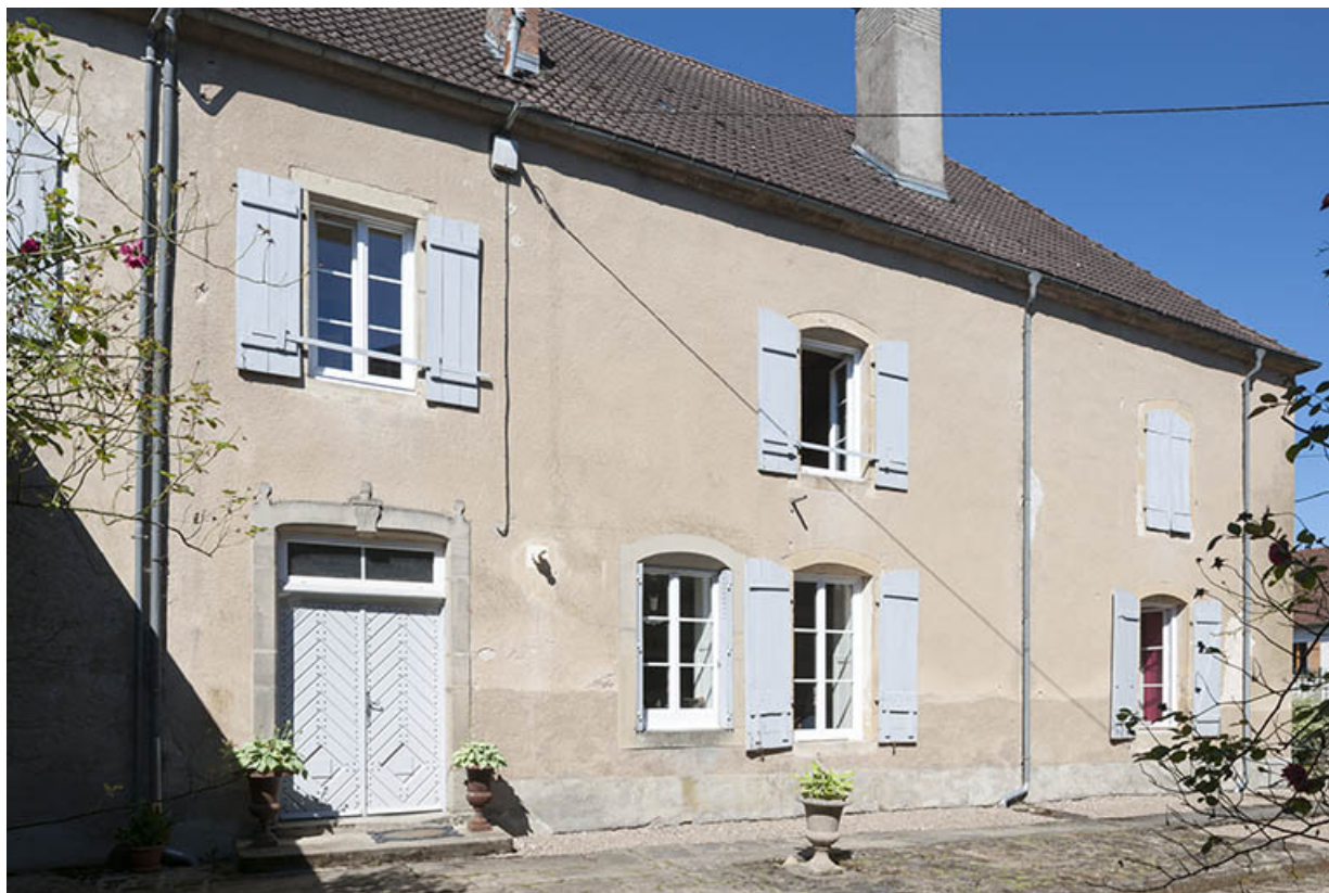
Vue générale, façade est.
