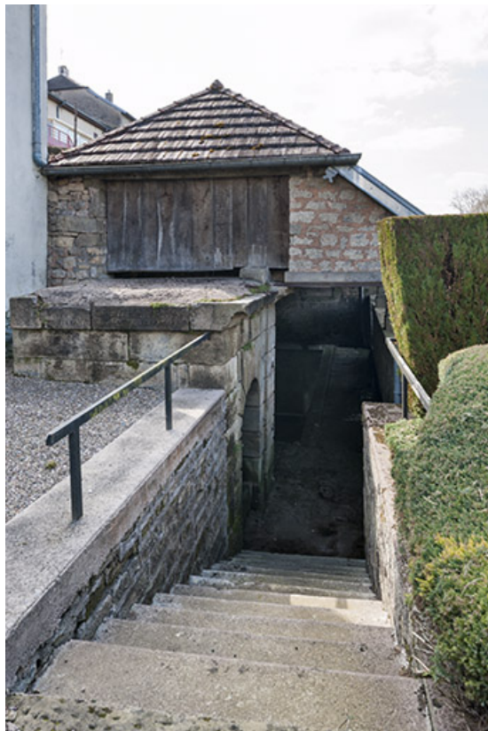
Le lavoir et son accès depuis la rue du Cornot. 70, Ormoy
