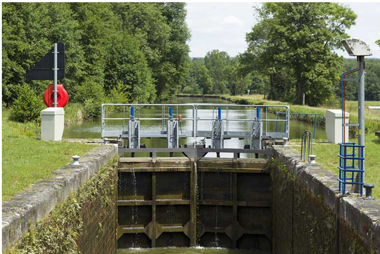
Portes amont fermées : le sas se vide.
