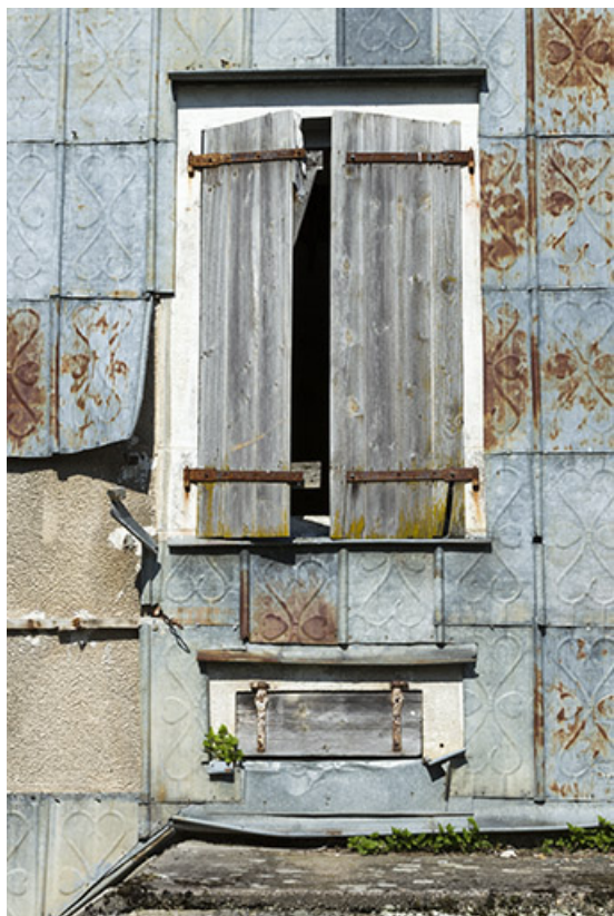
Détail de deux baies et de l'essentage de la façade sud-ouest. 70, Demangevelle
