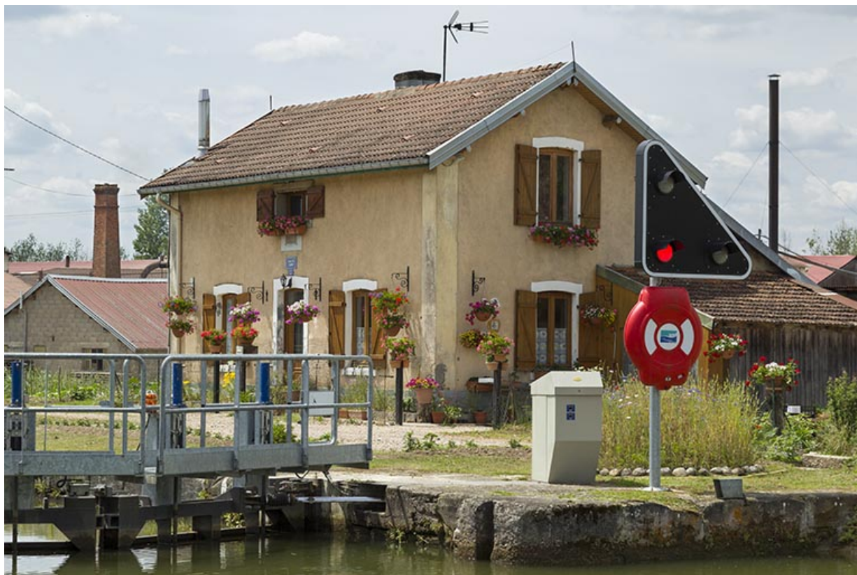
Vue de trois-quart sud-est de la maison d'éclusier depuis la rive gauche.
