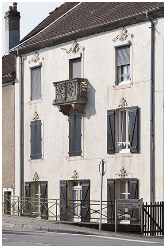
Façade antérieure sur la rue du Général Détrie : vue rapprochée.
