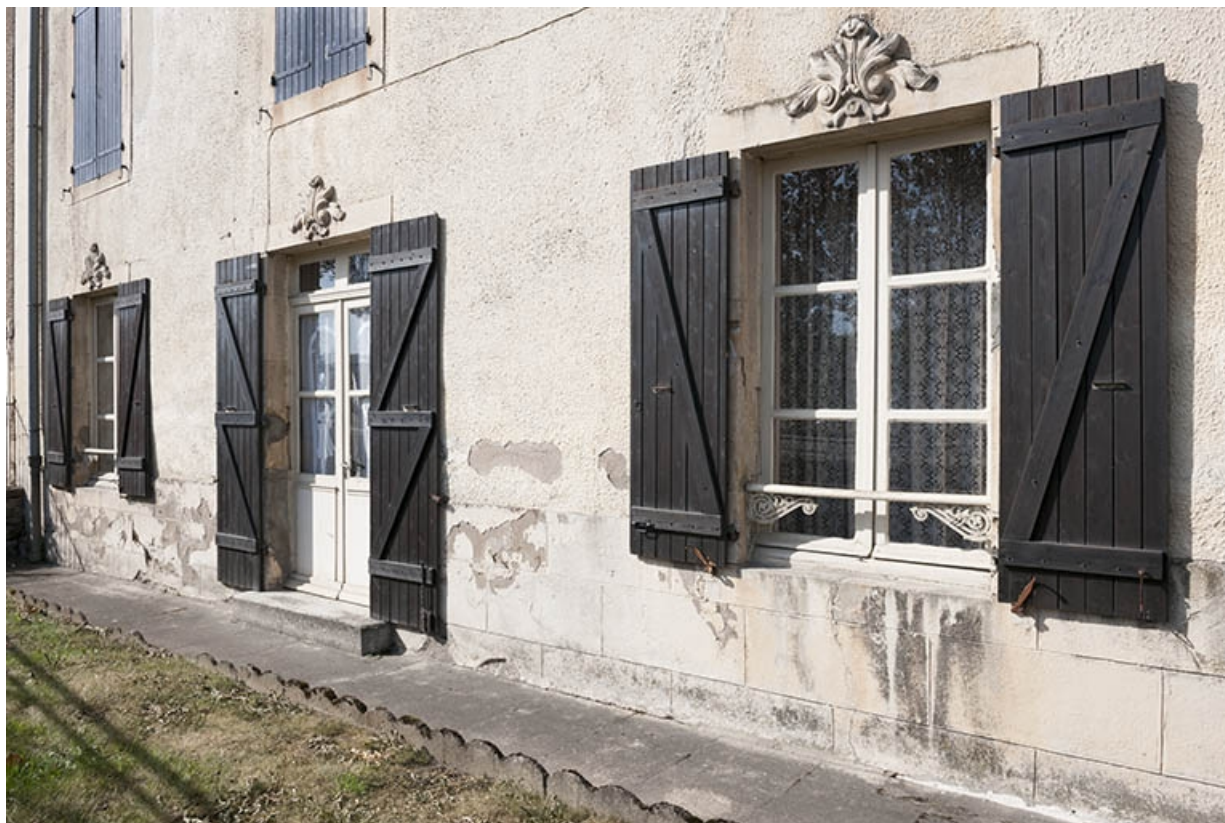
Façade antérieure : le rez-de-chaussée.
