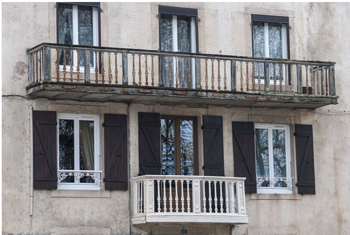
Façade latérale droite (avenue de la Gare) : les balcons à garde-corps en fonte. 70, Faverney, 1 avenue de la Gare
