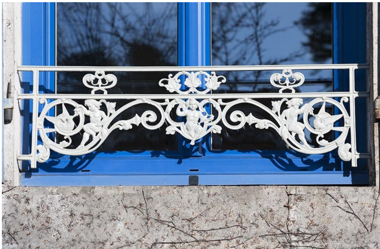
Vue d'ensemble de la barre d'appui, côté rue.
