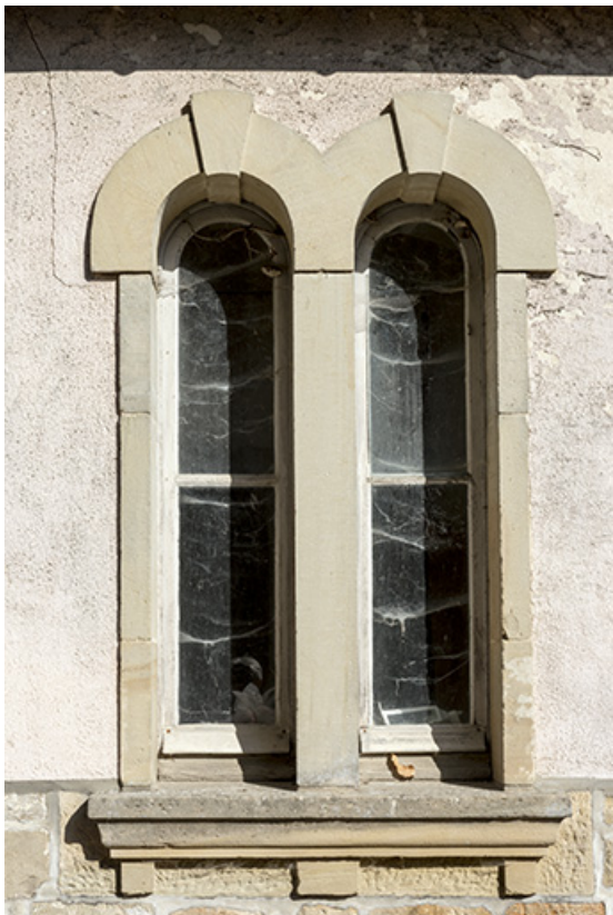
Détail des baies jumelées de l'ancienne dépendance.
