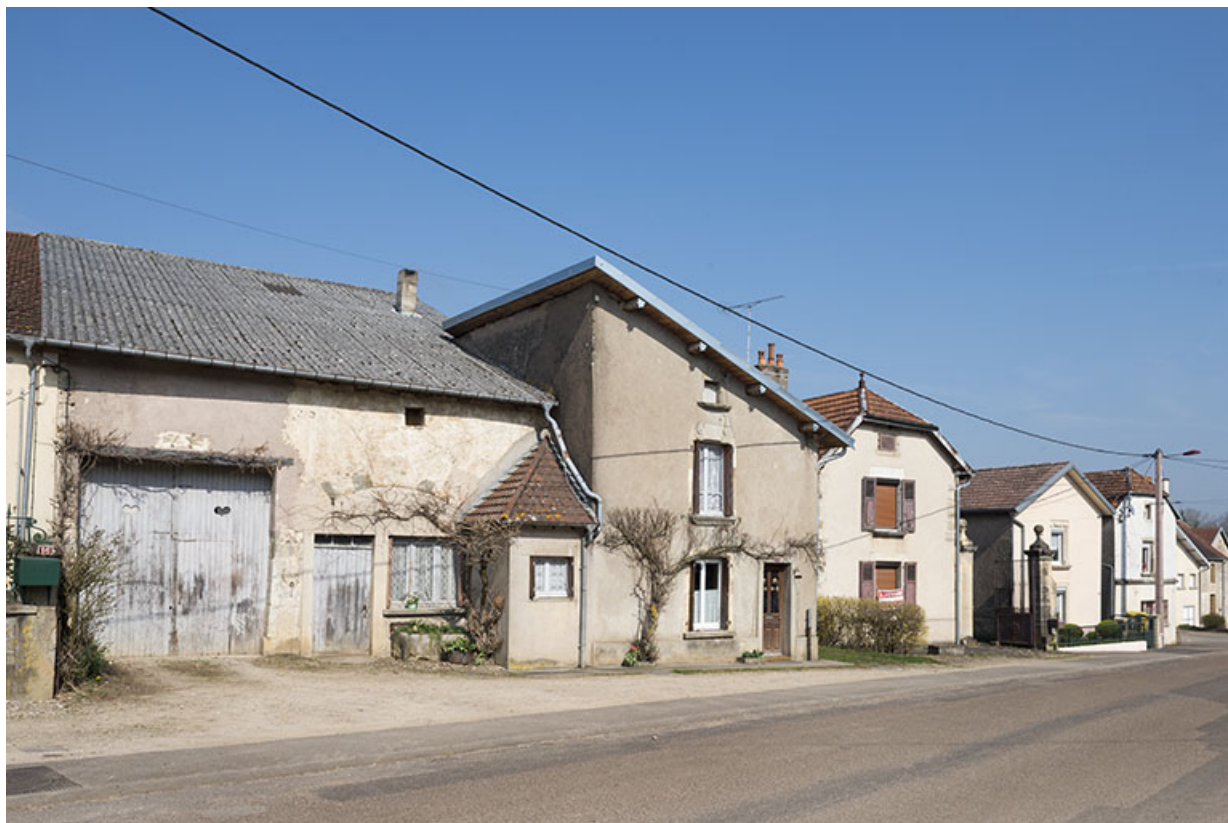
Vue générale, Grande rue.
