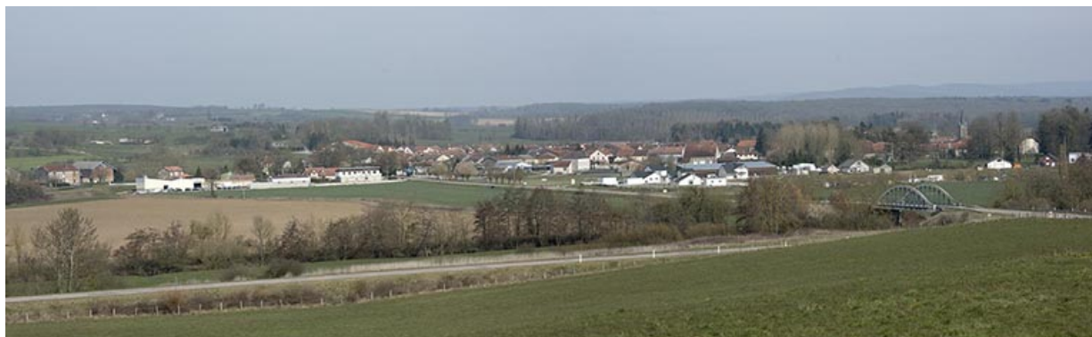
Vue générale depuis le sud-ouest.
