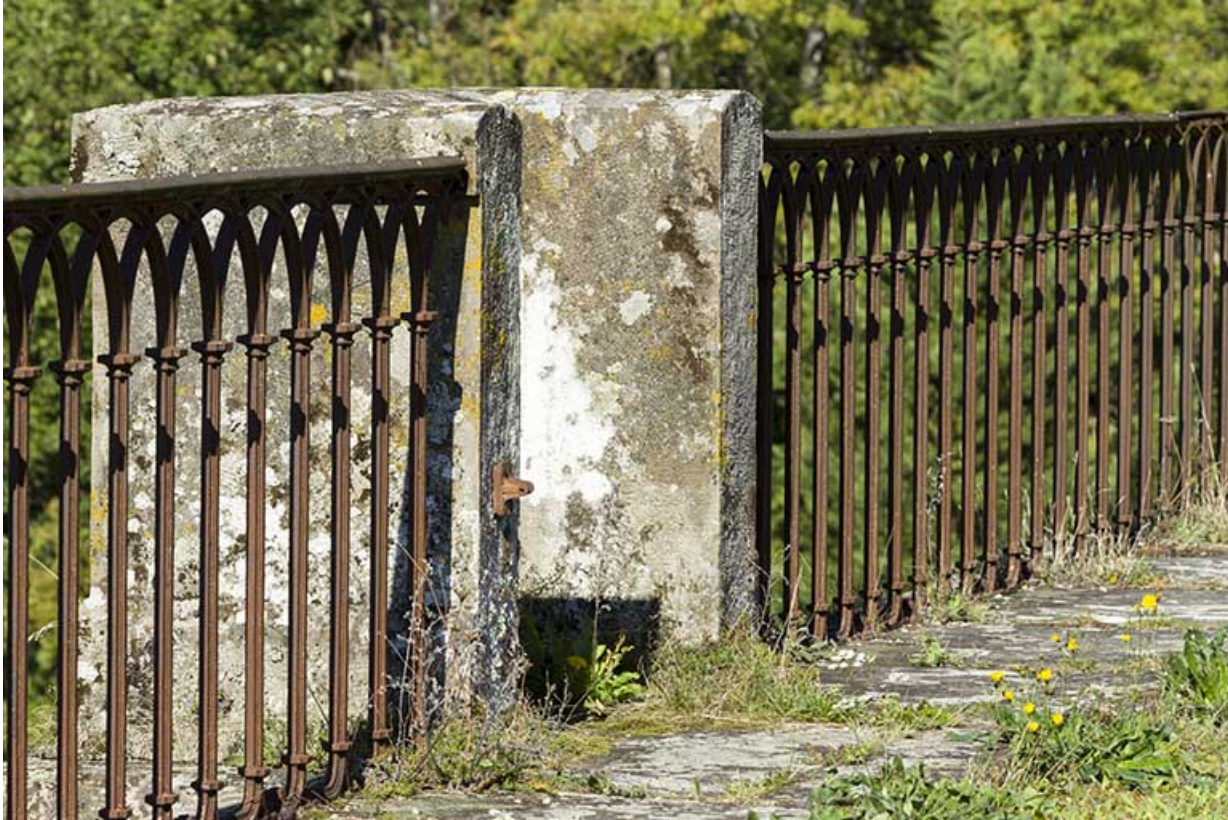
Le garde-corps maçonné d'une culée.
