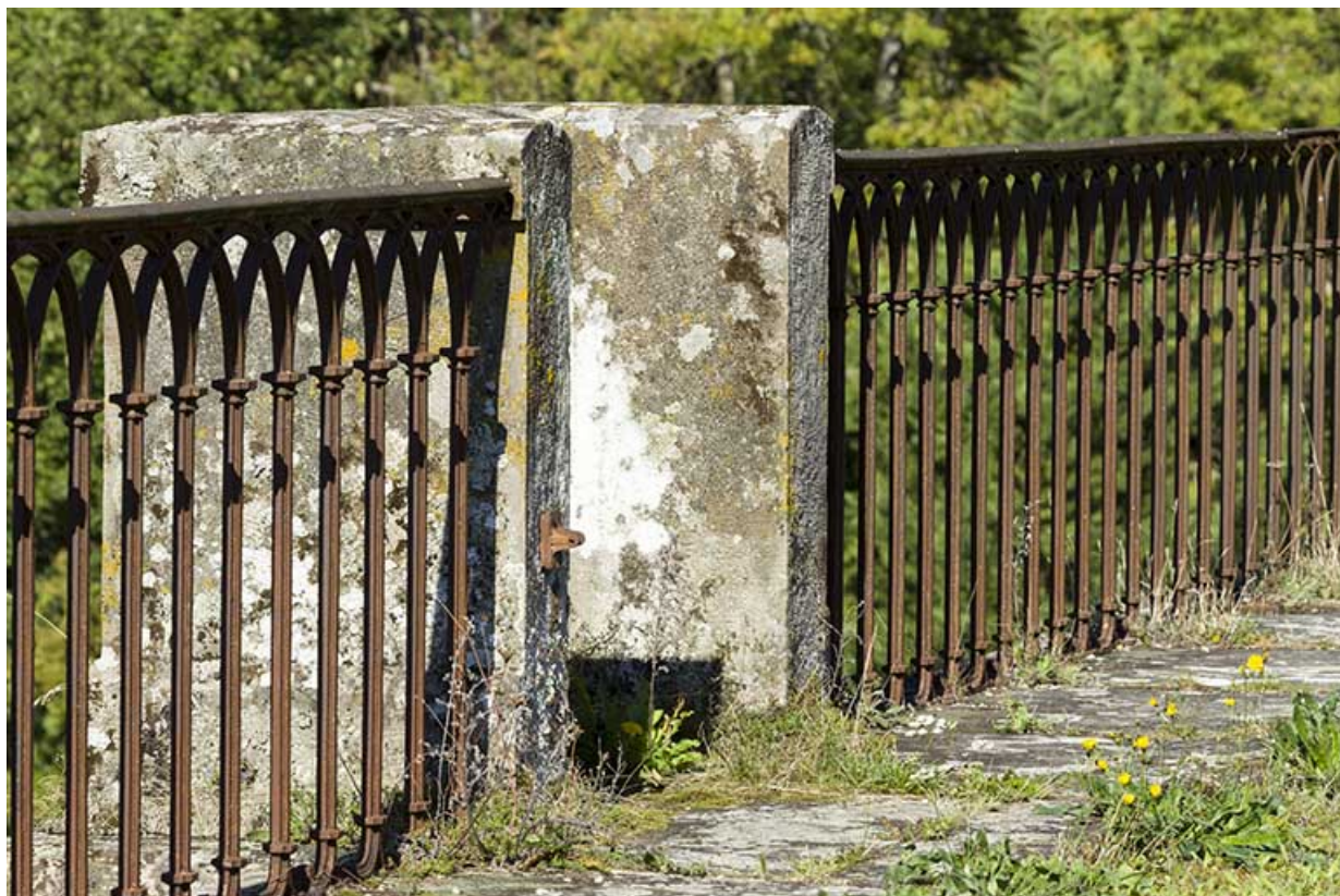
Le garde-corps maçonné d'une culée.
