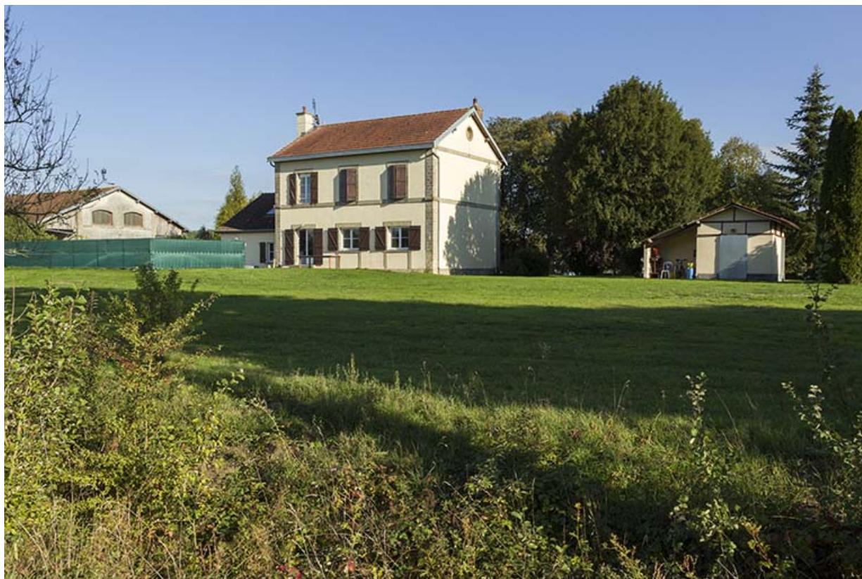
Vue de trois-quart nord-ouest de la façade sur voie de l'ancienne gare. 70, Corre avenue de la gare
