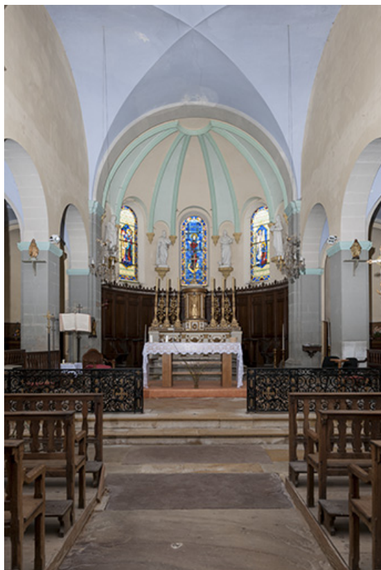
Vue générale du chœur. 70, Ormoy rue de l' Église
