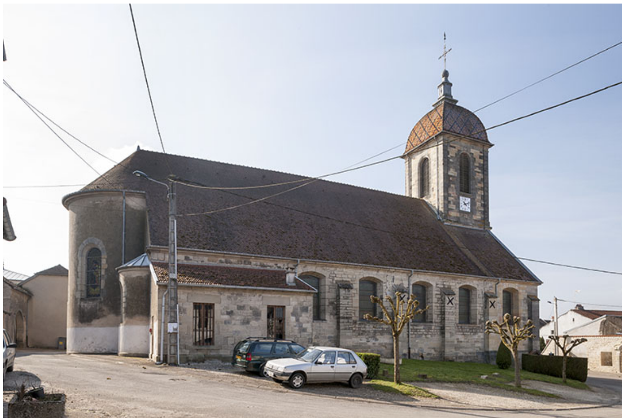
Vue sur la façade nord.
