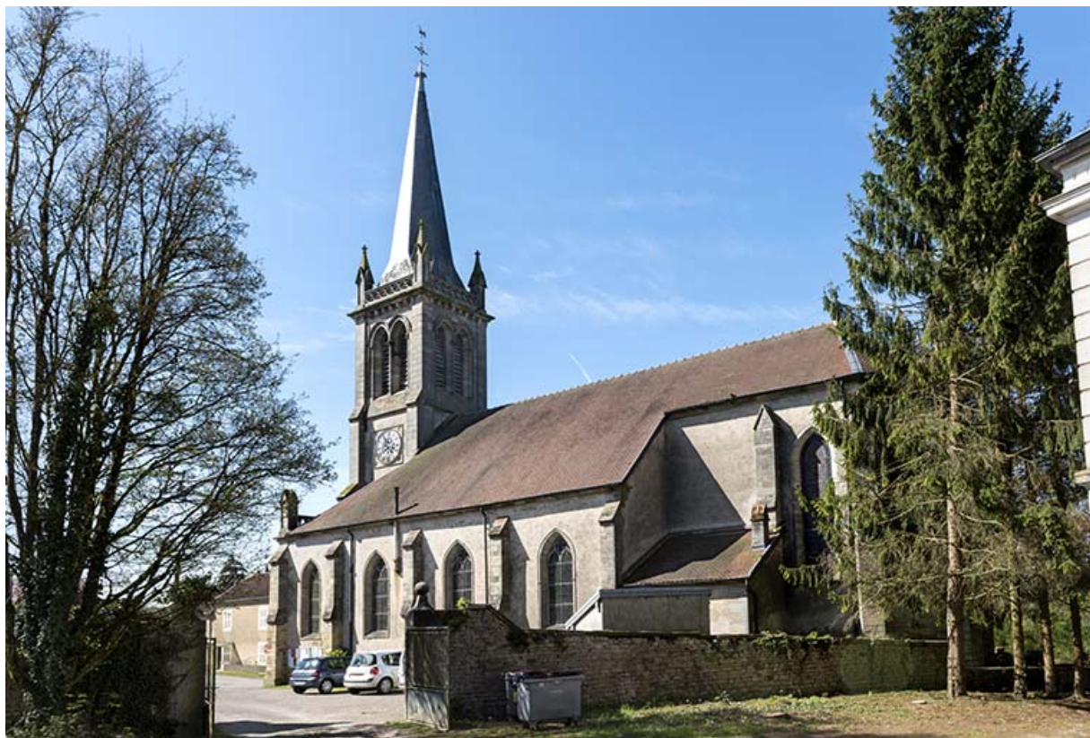
Vue d'ensemble depuis le parc du château.
