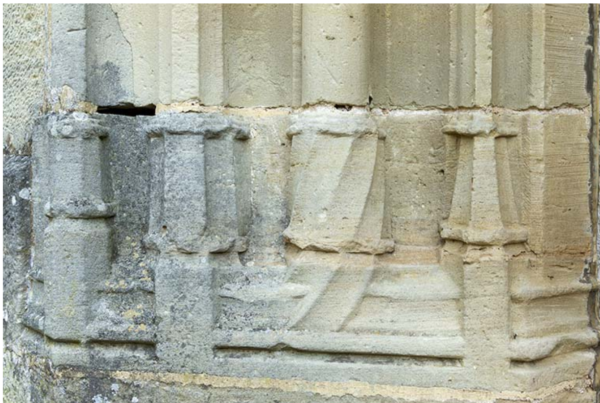
Détail de la base du piédroit gauche.
