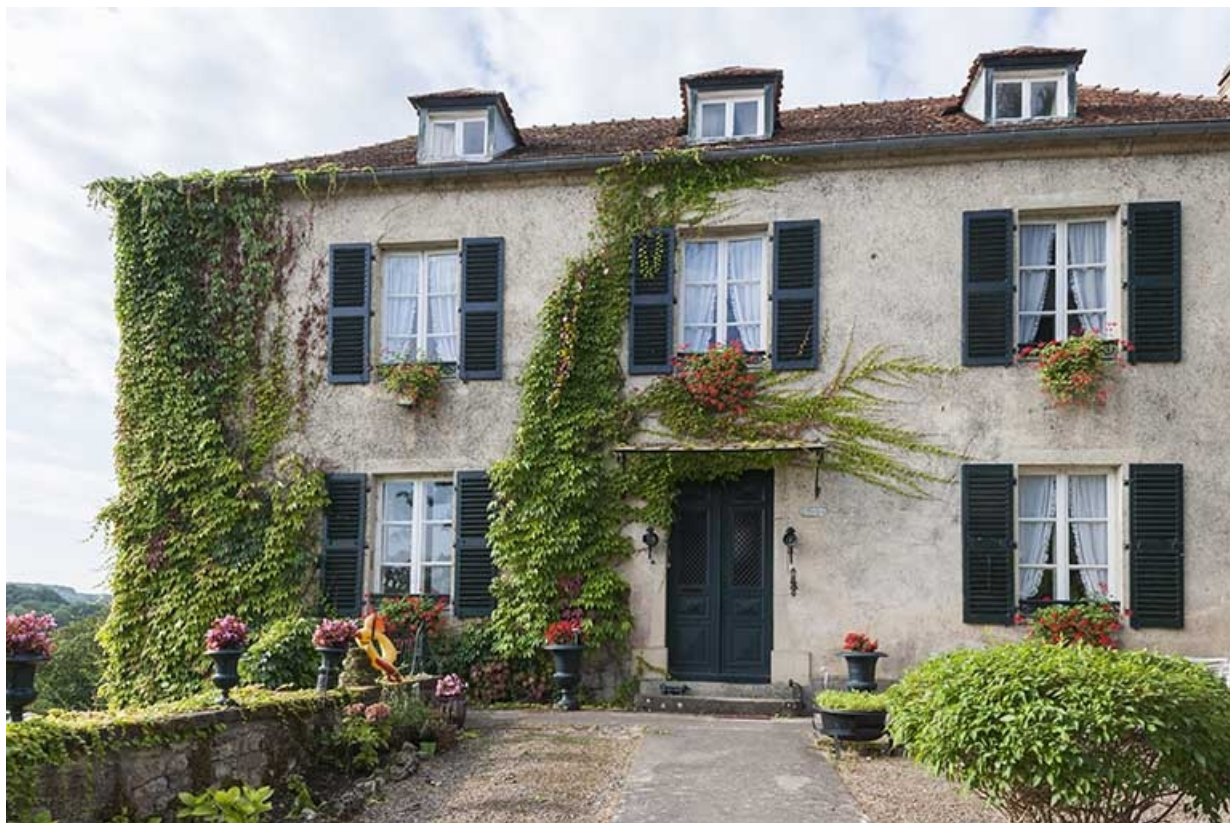
Façade antérieure sur cour.
