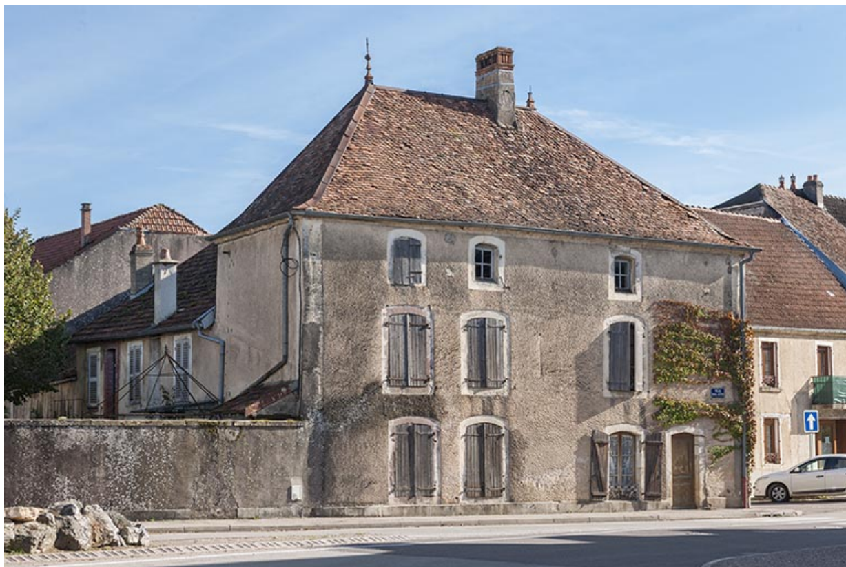
Vue générale depuis la place du Général de Gaulle.
