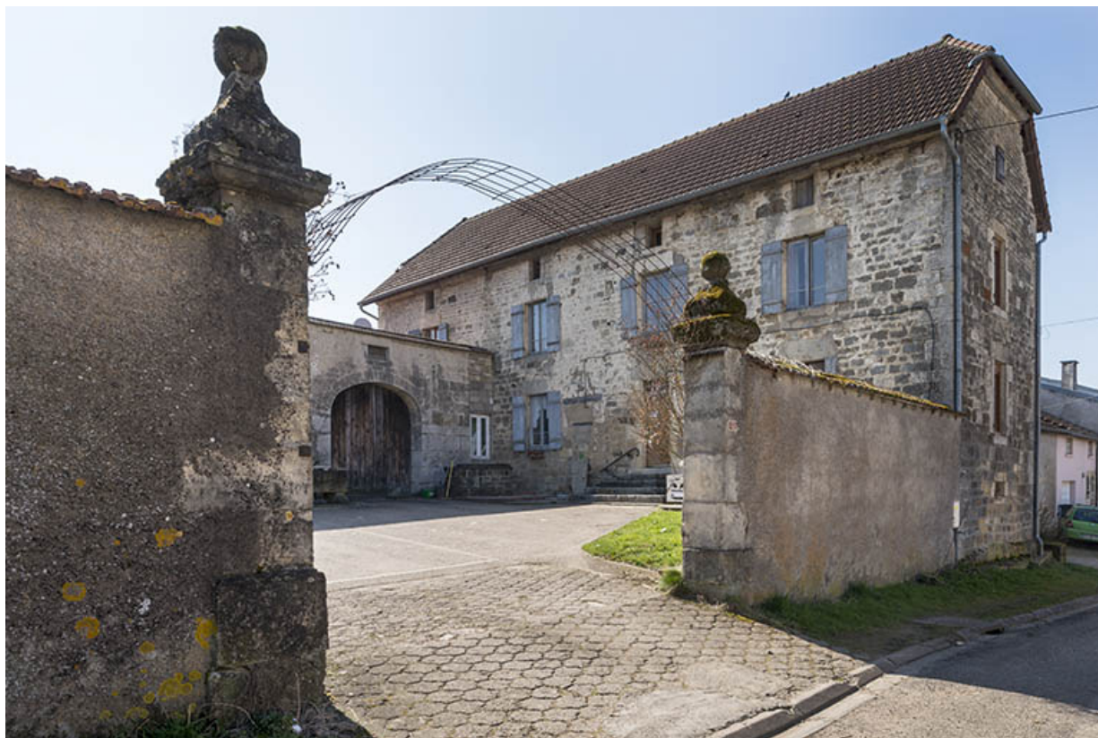
Maison située Grande rue. 70, Gevigney-et-Mercey
