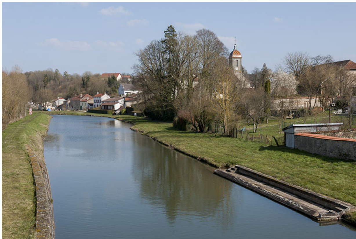
Le bief construit à Ormoy, afin de relier Corre à Port-sur-Saône. 70, Ormoy
