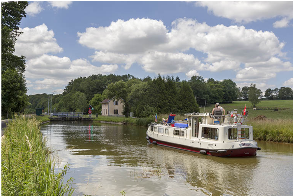
Vue d'ensemble depuis l'amont.
