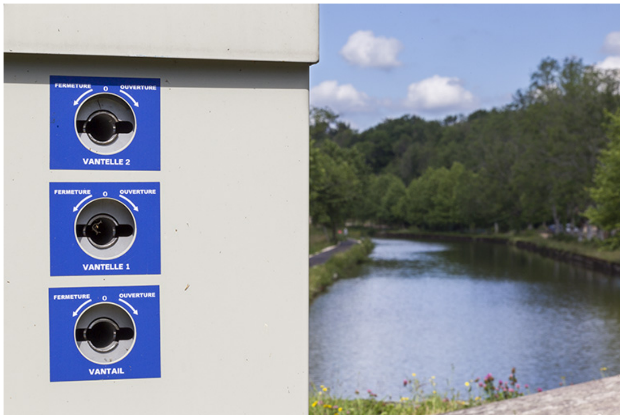
Commandes pour l'ouverture et la fermetures du vantail et des vanteles. 70, Selles
