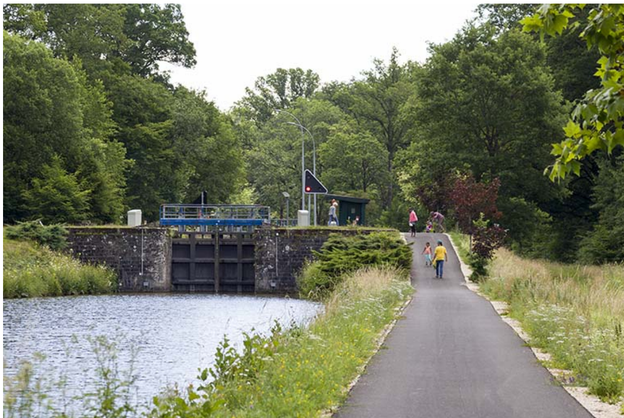
Vue d'ensemble depuis l'aval. 70, Selles
