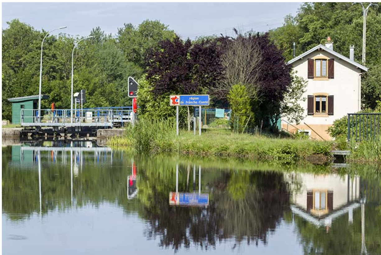
Vue d'ensemble depuis l'amont.
