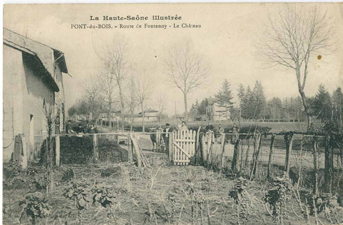
Route de Fontenoy (actuelle route départementale), carte postale. 70, Pont-du-Bois
