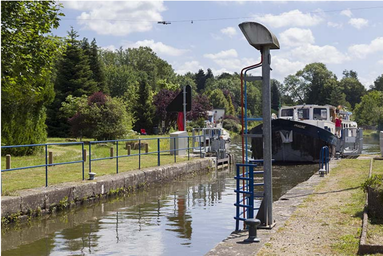
L'écluse de Pont-du-Bois.
