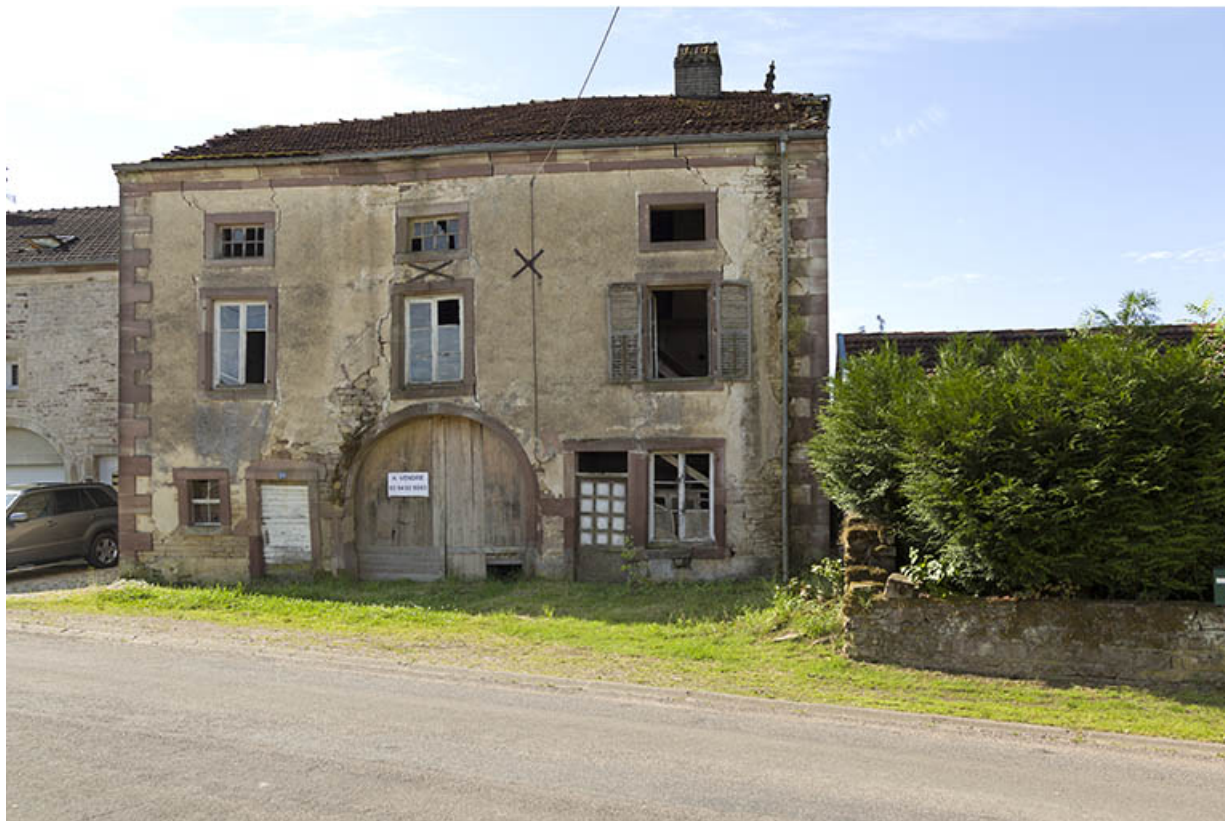
ferme, Grande rue. 70, Ambiévillers
