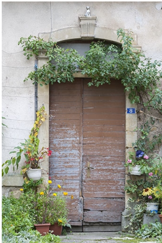
Façade antérieure sur cour (rue Bossuet) : la porte d'entrée.
