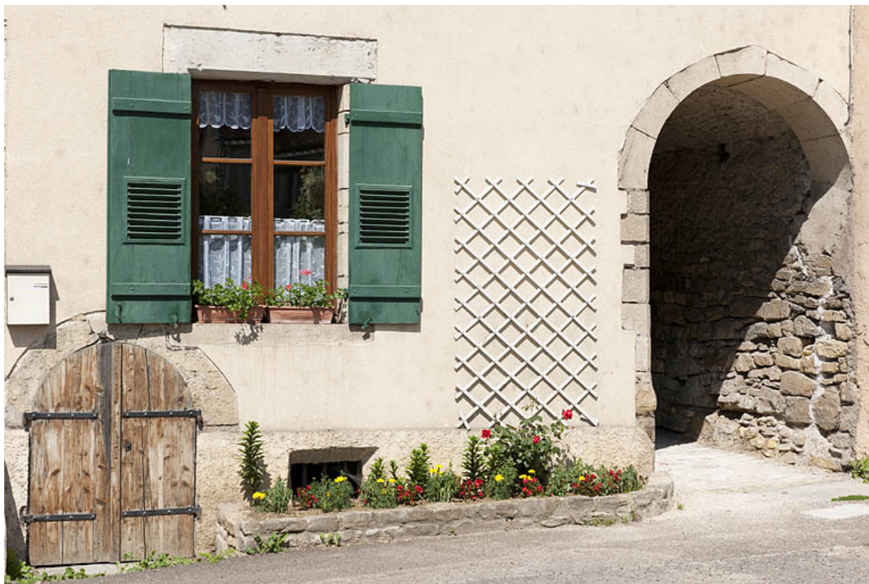
Maison, 7 Grande Rue, détail : le rez-de-chaussée surélevé sur cave. A droite, l'entrée de la rue de la Liberté (ou "treige") en direction de la rue des Ruaux.
