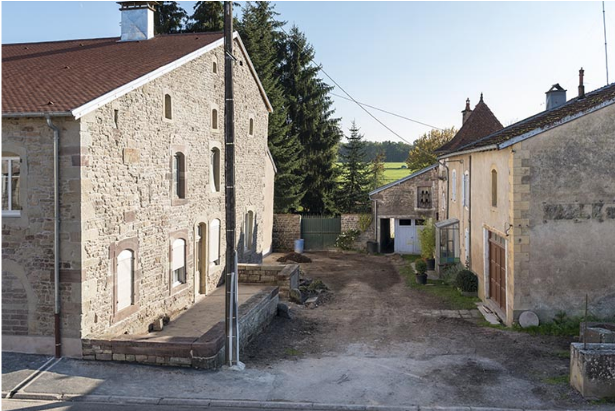
Vue du mur pignon ouest.
