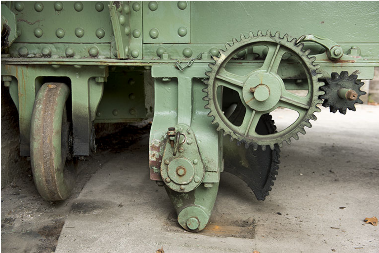
Détail du système de calage du pont.
