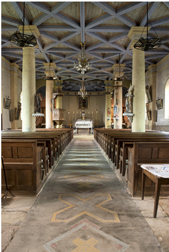
Vue intérieure de la nef.
