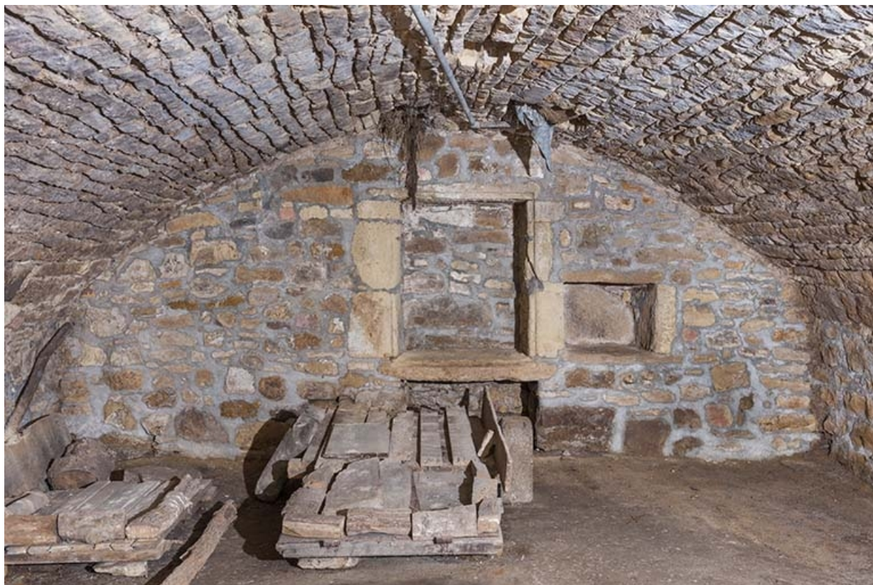
Ferme, 23 Grande Rue : cave voûtée et placards aménagés dans le mur du fond, face à l'entrée. 70, Faverney, 23 Grande Rue
