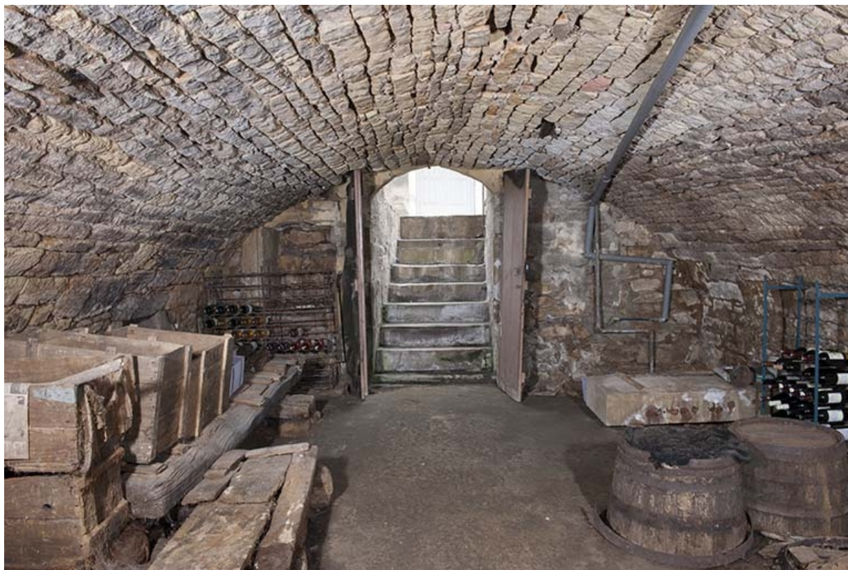
Sous-sol, en direction de l'entrée.
