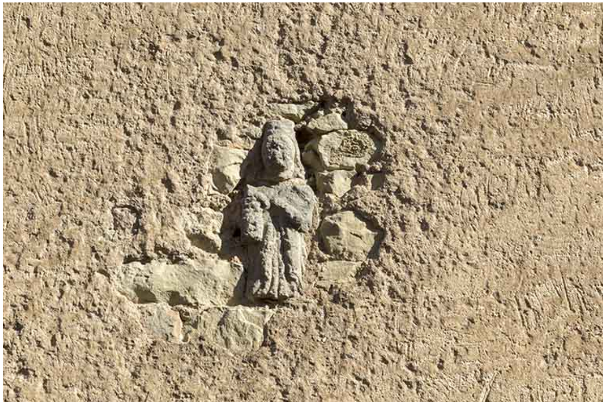
Détail de sculpture incluse dans le mur sud du presbytère.
