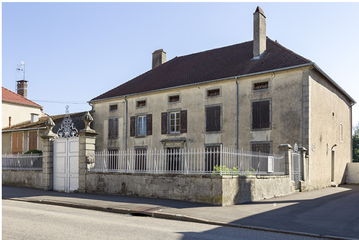
Vue de trois quart sud-ouest depuis la rue.
