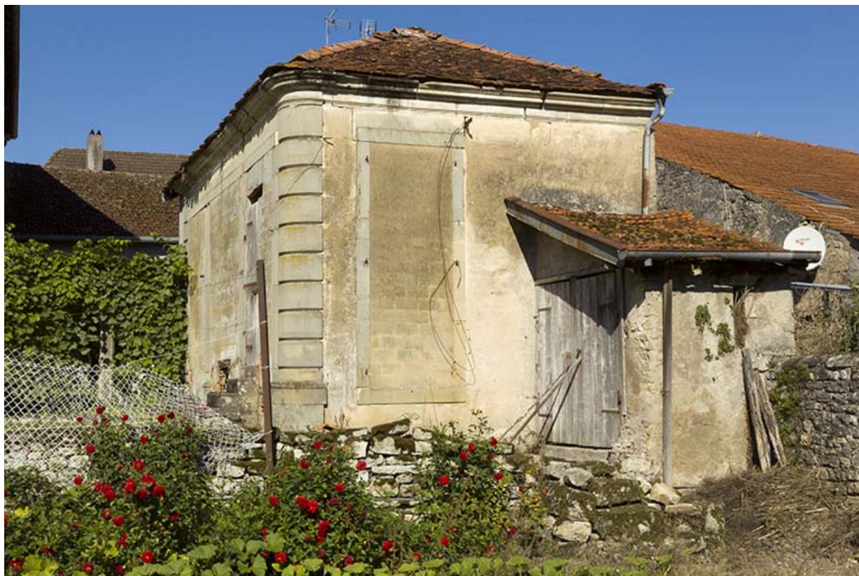
Vue de trois-quart du pignon est et de l'appentis de l'édicule de jardin.
