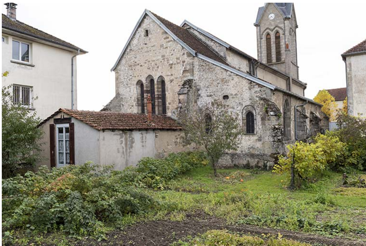
Vue d'ensemble nord-est.
