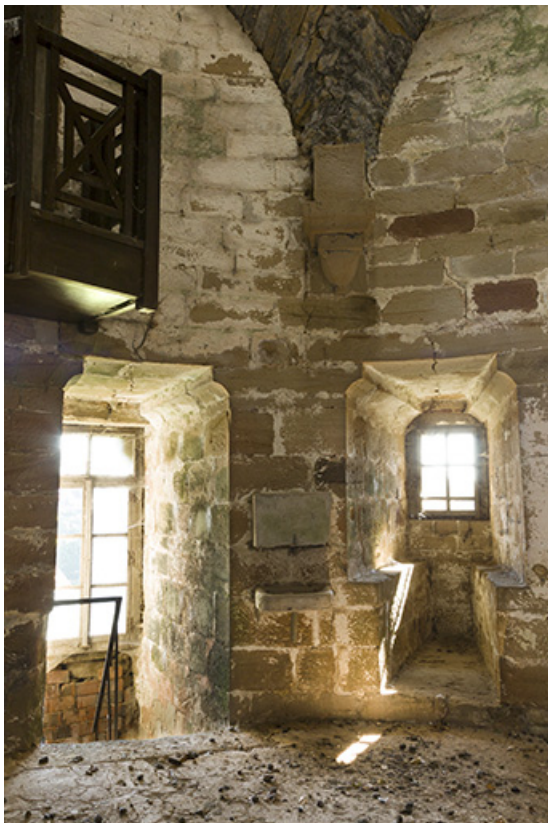
Détail d'une baie du premier étage du donjon.
