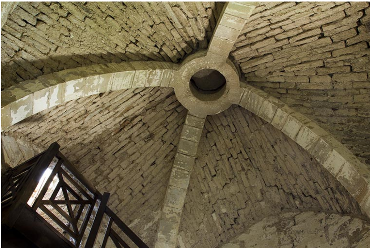
Le plafond voûté du rez-de-chaussée du donjon.
