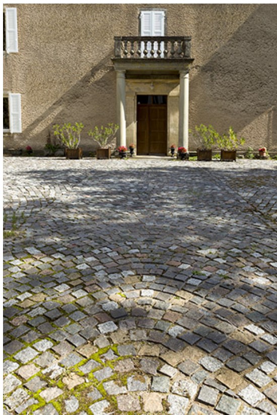
Détail du sol de la cour avec la porte d'entrée.
