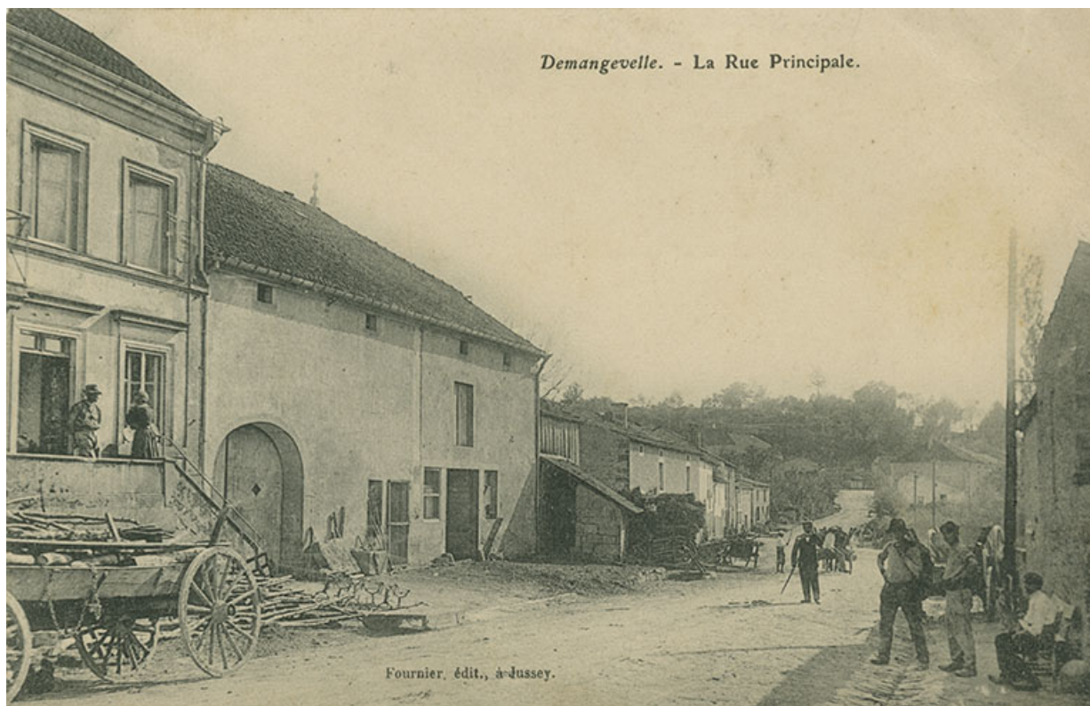
Demangevelle : la rue principale. Carte postale. 70, Demangevelle
