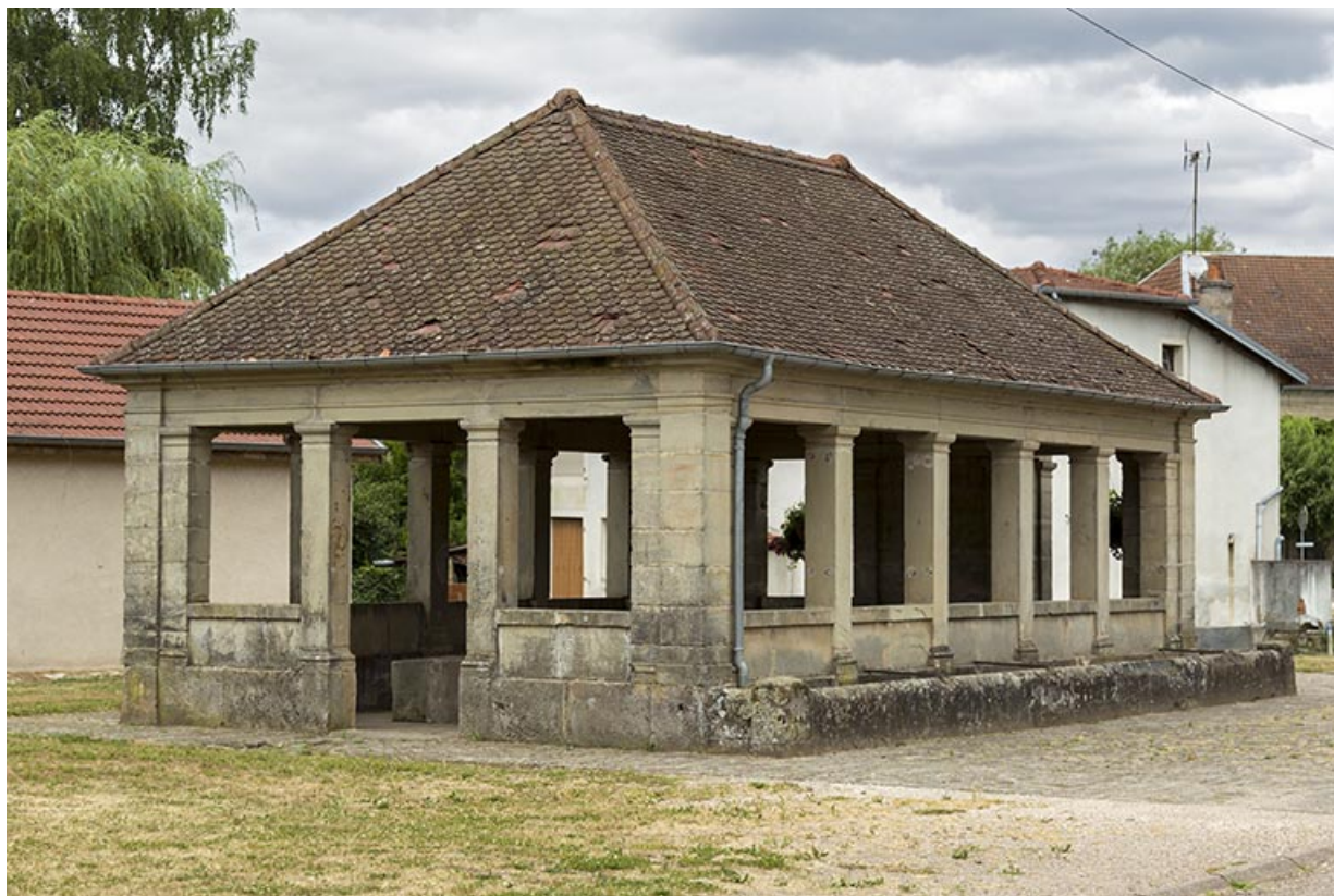
Le lavoir, rue Traversière. 70, Passavant-la-Rochère
