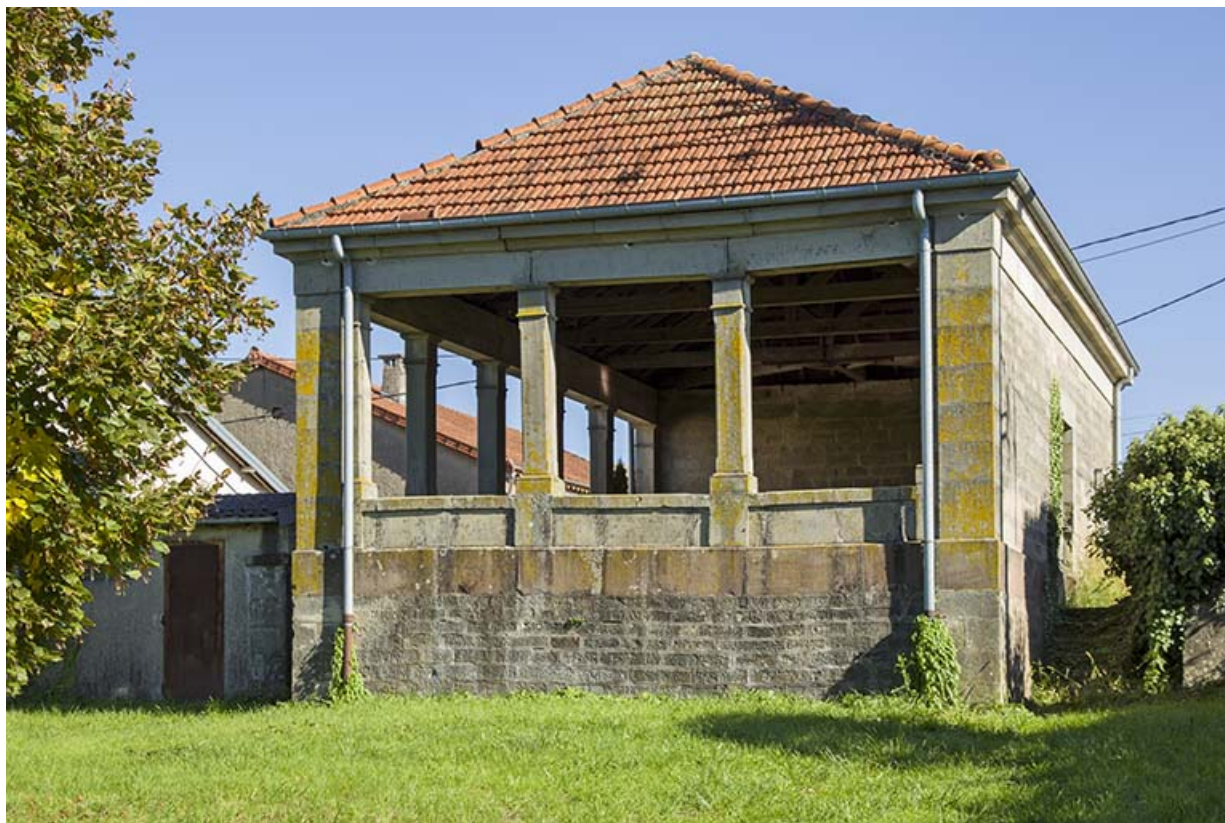
Façade sud de la fontaine-lavoir rue Saint-Antoine. 70, Passavant-la-Rochère
