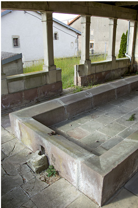
Bassin du lavoir rue Saint-Antoine.
