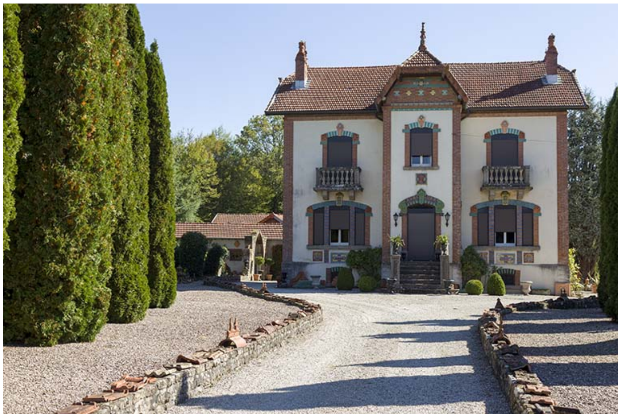
Ancien logement patronal. 70, Passavant-la-Rochère
