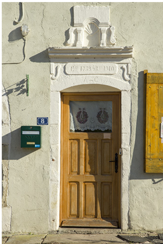
Détail d'une porte, rue Royale.
