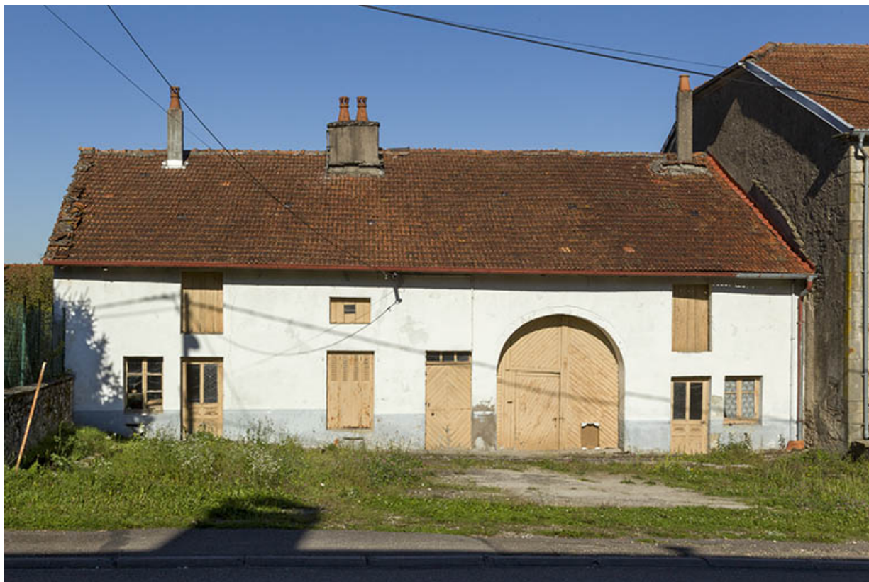
Ferme comprenant deux habitations et une partie agricole commune. 70, Passavant-la-Rochère
