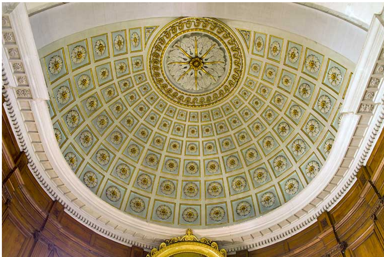
Voûte à caissons, chœur de l'église.
