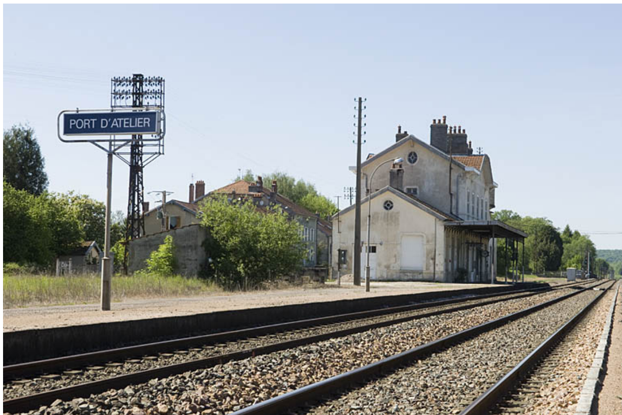
Gare de Port-d'Atelier : vue générale de la gare des voyageurs depuis le sud-est. 70, Favorney
