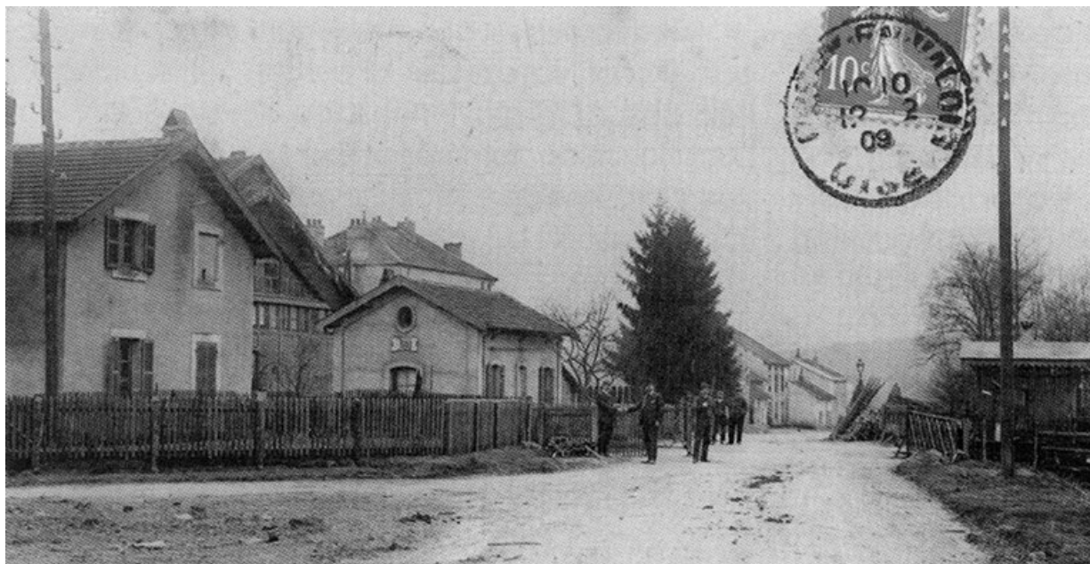
Maison de garde-barrière en gare de Port-d'Atelier-Amance, 1er quart 20e siècle. 70, Faverney
