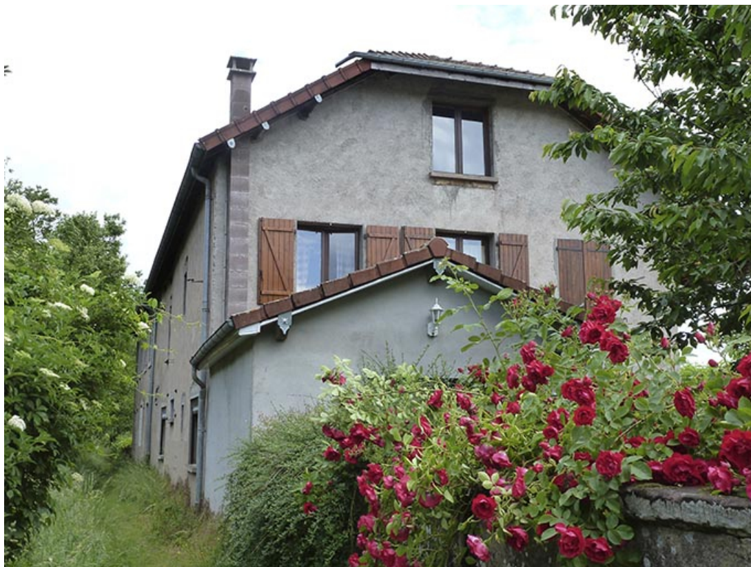
Bâtiment au long du canal : façade sud.
