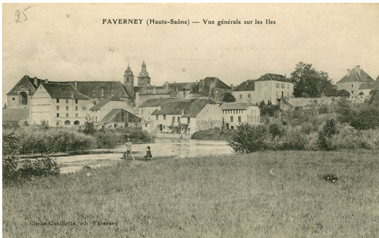
Favorney (haute-Saône) - Vue générale sur les Iles [vue d'ensemble des bâtiments sur la rive droite du canal du Moulin], limite 19e siècle 20e siècle.
