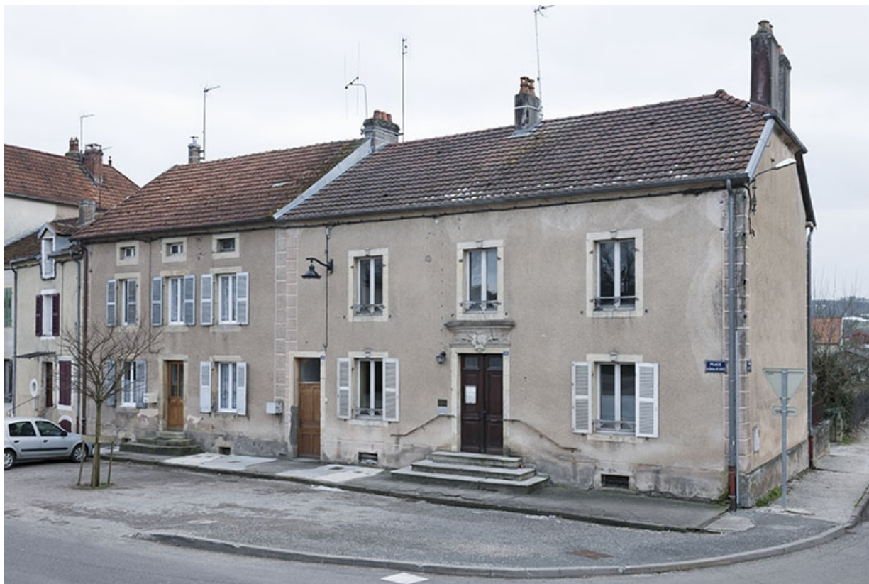
Vue générale de la maison (à gauche) et de sa voisine.
