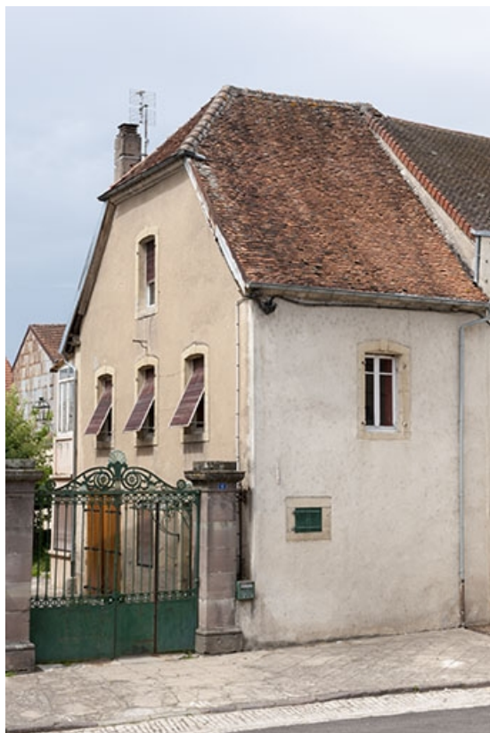
Partie droite de l'ancienne grange, actuellement occupée par des logements.
