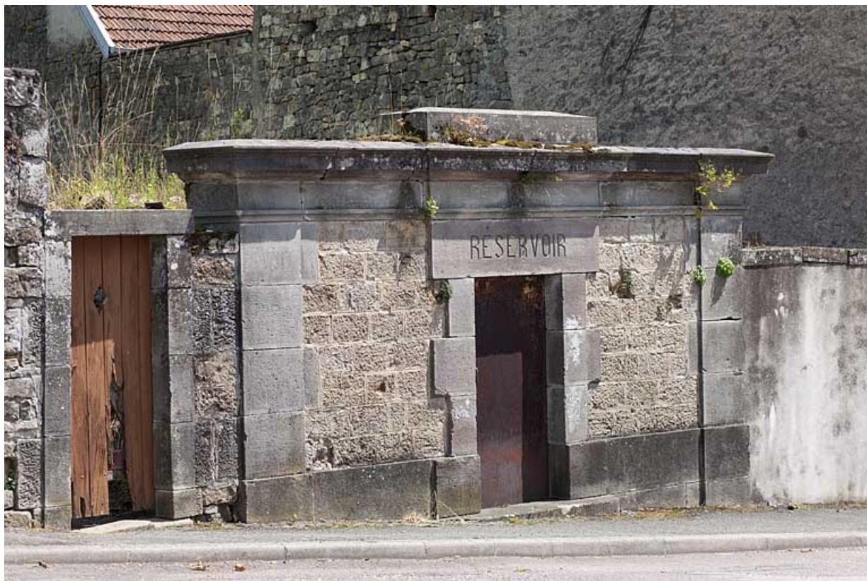
Le réservoir (AB 697), rue du Général Rébillot. 70, Favorney
