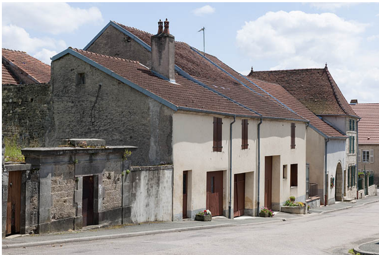
Vue partielle de la rue du Général Rébillot, avec au premier plan le réservoir. 70, Faverney
