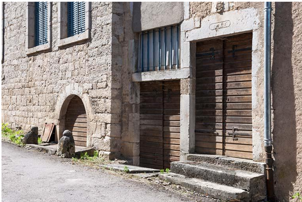
Maison de la partie est de la rue 70, Gy Rue du Bourg
