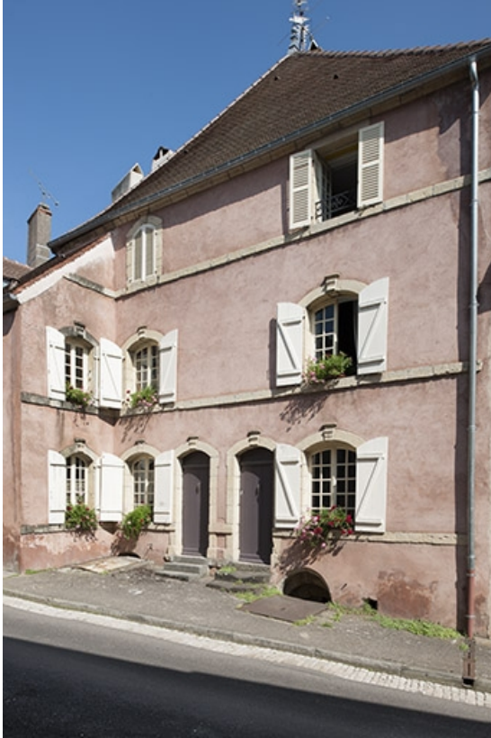
Maison dite des Hôtes : façade du 18e siècle au 4 rue Thiers. 70, Faverney
