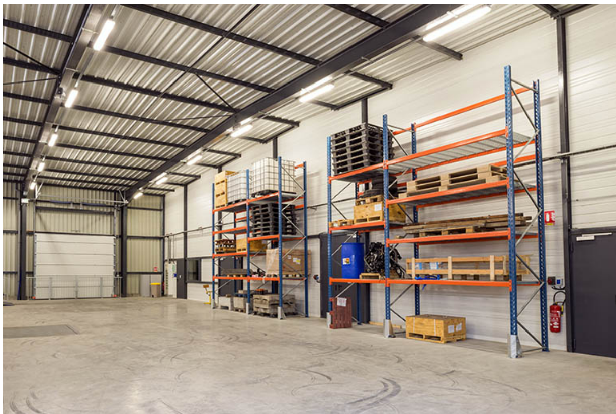
Vue intérieure des stockages dans l'atelier.
