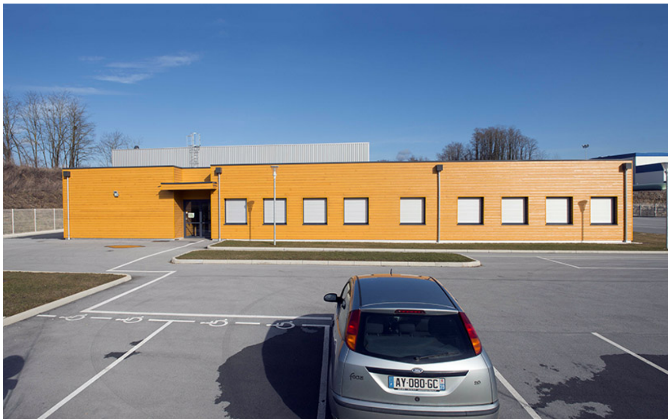
Façade antérieure ouest, entrée des salles de cours.
